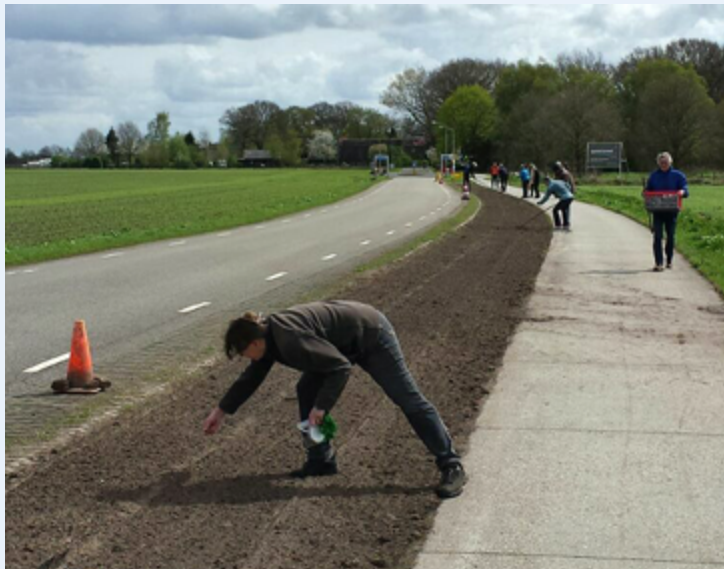
Inzaaien van een berm in Benneveld
